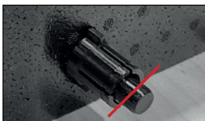
B) Conecte una de las salidas del tubo suministrado a la salida de condensados y el otro extremo al sifón, de manera que el sifón quede lo mas vertical posible.
